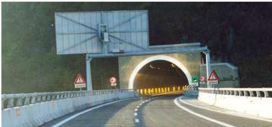
Abb. 29 Spiegel zur Tunnelbeleuchtung mit Sonnenlicht [22]
