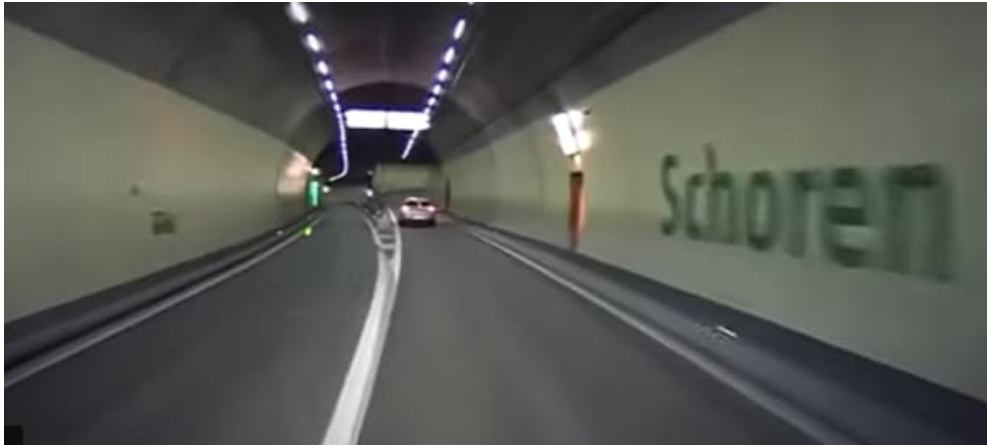
Abb. 7 Videostandbild aus dem Tunnel Schoren mit Abzweigung im Tunnel
