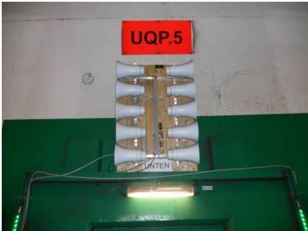
Abbildung 3 Aufbau der Lautsprechersysteme
